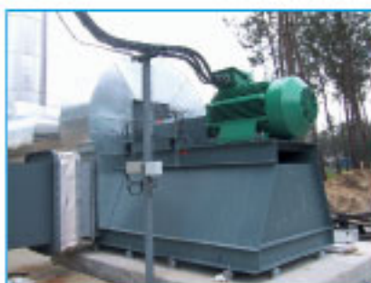
Akoestische isolatie van het ventilatorhuis.
