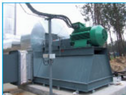
Volute de ventilateur acoustiquement isolée.
